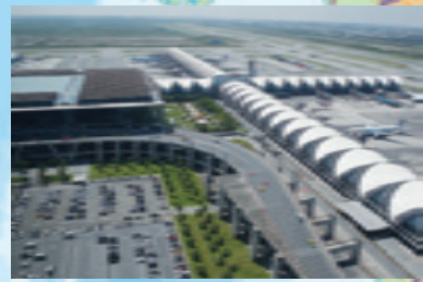
⑦ 第2バンコク国際空港建設事業 (スワンナプーム) Thailand: SECOND BANGKOK INTERNATIONAL AIRPORT DEVELOPMENT PROJECT
