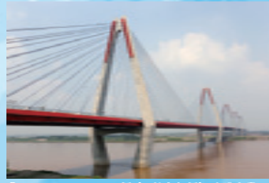
⑩ ベトナム ニャタン橋 (日越友好橋) 建設事業 Viet Nam: Nhat Tan Bridge (Vietnam-Japan Friendship Bridge) Construction Project
