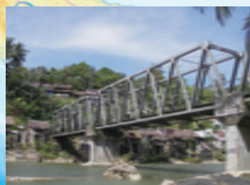
③ インドネシア ニアス島橋梁復旧計画 Indonesia: The Project For Improvement Of Bridges In Nias Island
