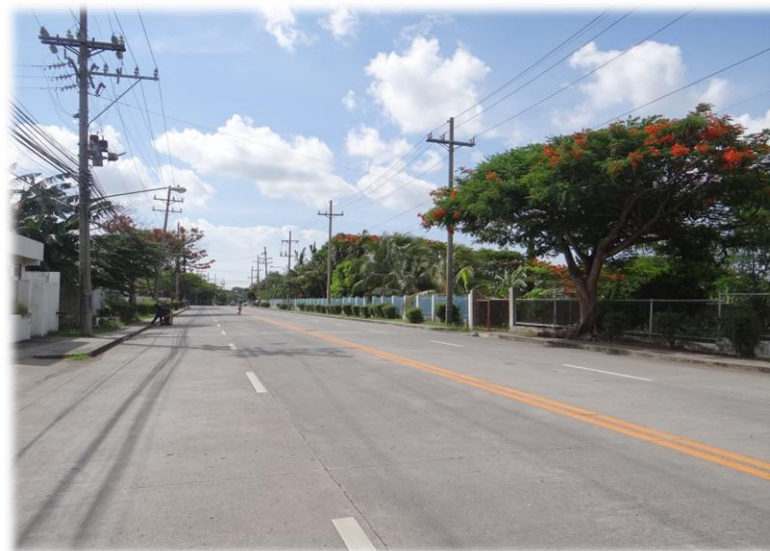
主要工業団地内は、電気・水道など基礎インフラは整っている
